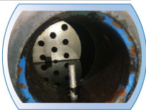
使用EWT的一级冷却器 (使用8个月)
