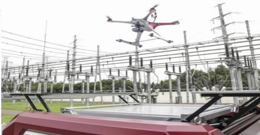
图 4-7 无人机实现电力设施智能巡检
