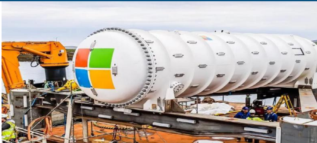
图表161： 微软 Natick 项目第二阶段——水下数据中心
